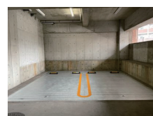
車止め、ライン引き (完成)
