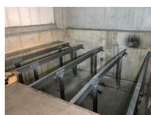
支柱、梁の組立
